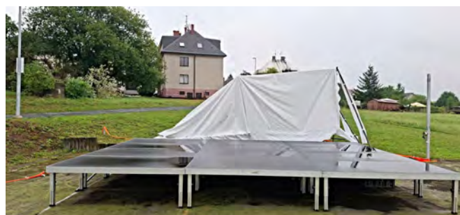
Páteční déšť a vítr položily konstrukci pódia k zemi.
